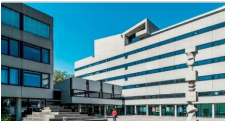
Allgemeine Gewerbeschule Basel, Basel Sanierung - neue Gebäudehülle und Lüftungsanlage
