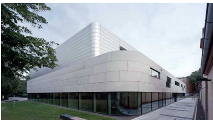
Forschungssporthalle der Humboldt-Universität, Berlin 3 Accublocs, total 8'800m 3 /h
