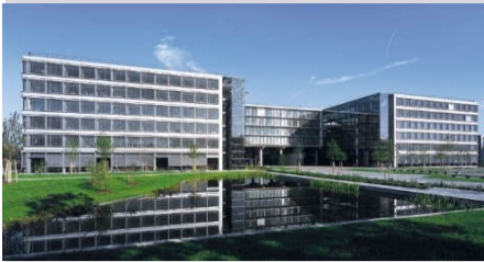
DFS Deutsche Flugsicherung GmbH, Frankfurt 1 Accubloc, total 30'000m 3 /h
