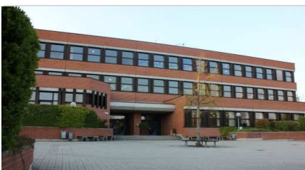
Mittelschule, Mainburg 1 Accubloc, total 3'000m 3 /h
